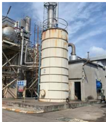
ภาพที่ 8 ถึงเก็บกักน้ำขนาด 75 ลบ.ม.
