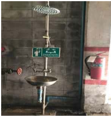
ภาพที่ 29 อ่างล้างตาและร่างกายฉุกเฉิน
